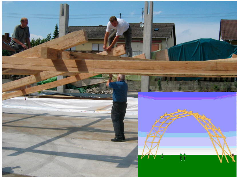
Probeaufbau der Leonardobrücke in Schriesheim, und so soll sie aussehen.
